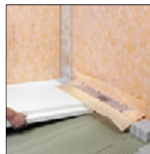
zu 3. Ausgleichsboard ebenflächig verlegen
