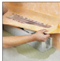
zu 2. Rinnenkörper einsetzen
