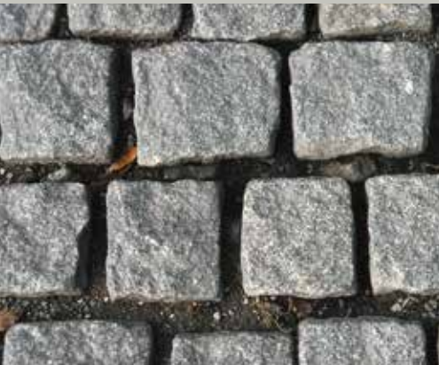
Reinigungsprozess und Regenwasser führen zum Entleeren ungebundener Fugen
