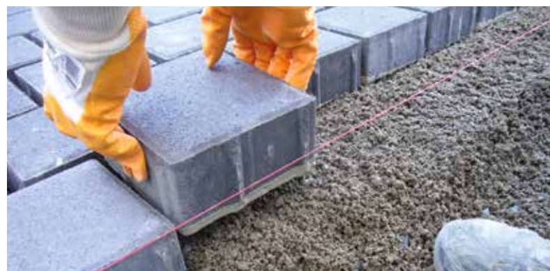
Versetzen von unterseitig mit Sopro HaftSchlämme Flex HSF 748 vorbehandelten Steinen „frisch-in-frisch“ in die Bettung aus Sopro DrainageMörtel DM 610
