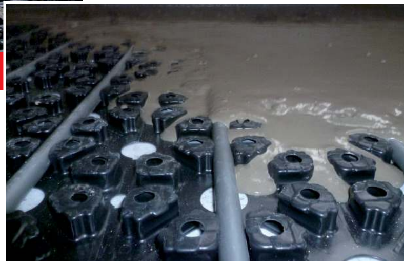
Der Sopro FaserFließspachtel FAS 551 fließt in das Heizungs-system ein.
