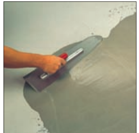
Die Spachtelmasse wird mit einer Glättkelle verteilt und verläuft selbstständig zu einer ebenen, ansatzfreien Fläche.
