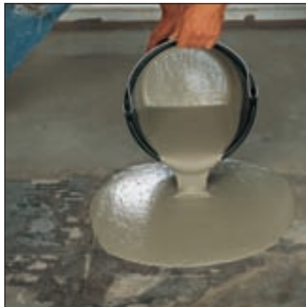
Sopro Fließspachtelmassen werden „frisch-in-frisch“ auf den mit Sopro Haftemulsion vorbehandelten Untergrund ausgegossen.
