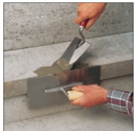
Beschädigte Treppenstufen, tiefe Löcher und Ausbrüche werden mit der schnell erhärtenden Spachtelmasse Sopro SchnellSpachtel repariert.
