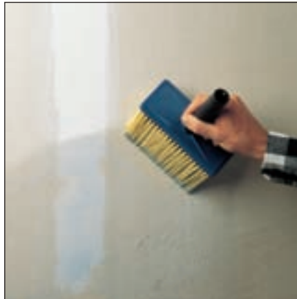
Sopro Grundierung wird mit Quast oder Lammfellrolle vollsatt auf den saugenden Untergrund aufgetragen.
