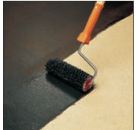
Sopro Haftkraft oder Sopro HaftPrimer S wird möglichst dünn mit der Lammfellrolle auf den nicht saugenden Untergrund aufgetragen.
